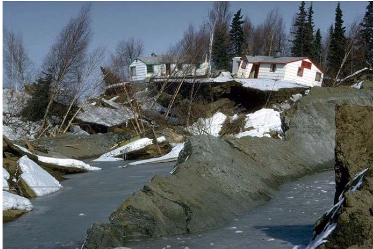
Escorregamento de terrenos (Faial, 1998)
